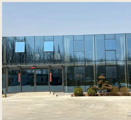
FIG. 02 ESCRITÓRIO E COORDENAÇÃO TÉCNICA
