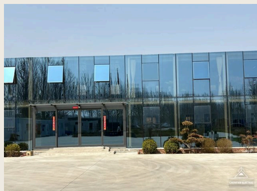
FIG. 02 OFICINAS Y COORDINACIÓN TÉCNICA
