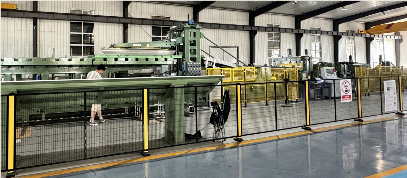
FIG. 05 LÍNEA AUTOMÁTICA DE CORTE A MEDIDA: ZONA DE PRODUCCIÓN PROTEGIDA
