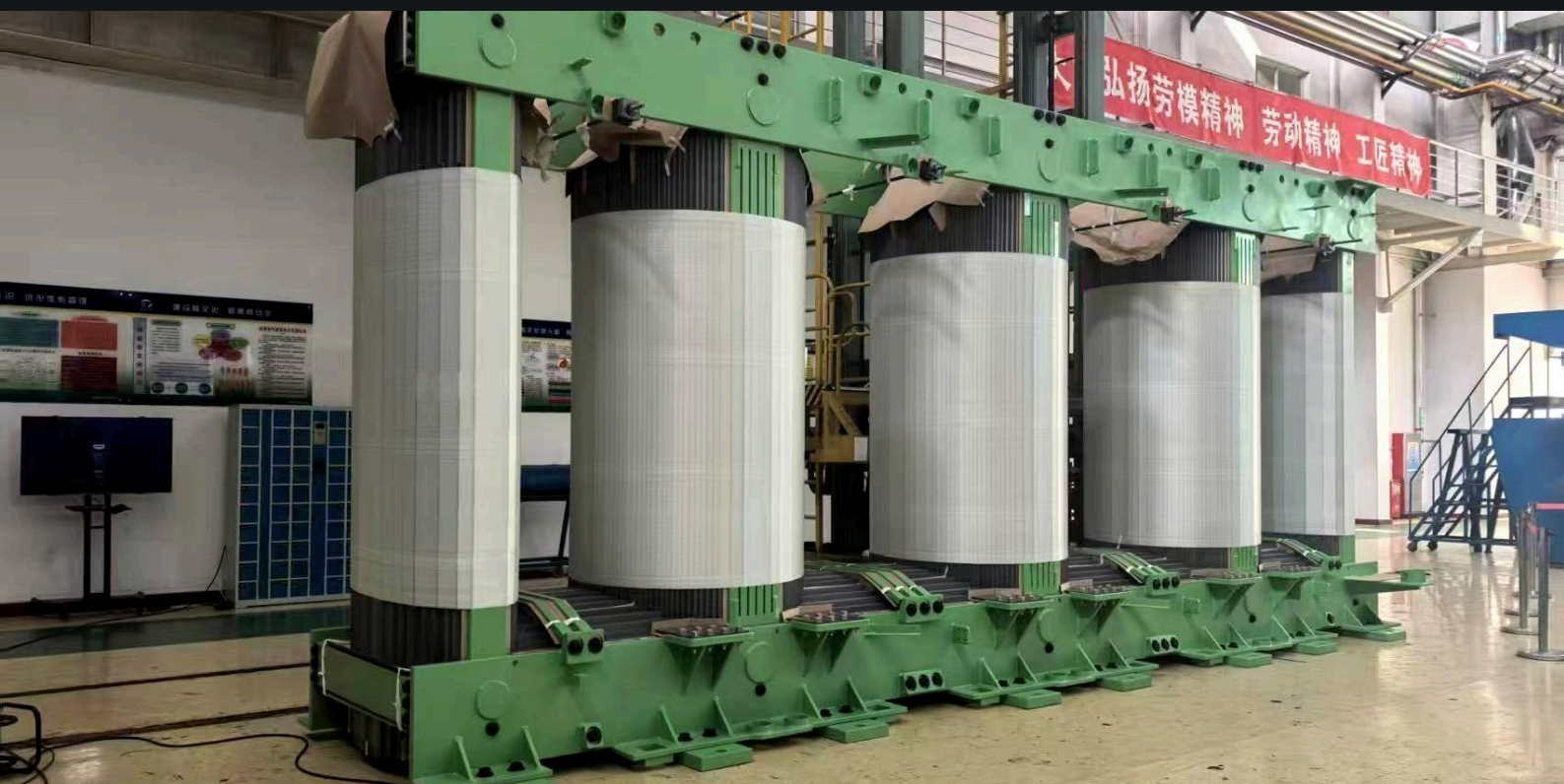
ABB. 12 GROSSER FÜNFSCENKEL-TRANSFORMATORKERN MIT SPANNRAHMEN - IM WERK MONTIERT
